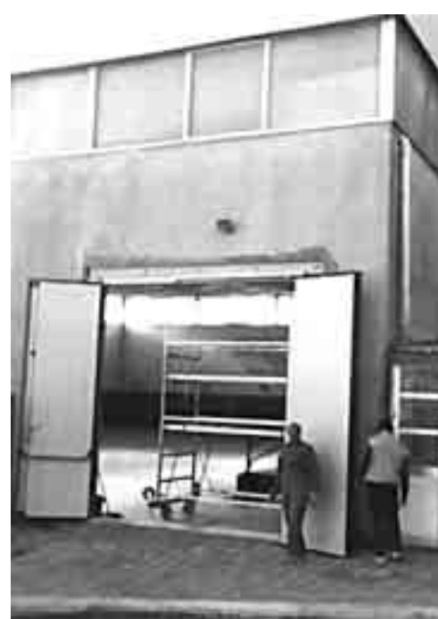
COLLOCATE LE PORTE ANTINTRUSIONE NELLA PALESTRA
